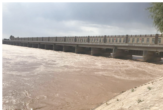
建于1959年的三盛公黄河水利枢纽工程
